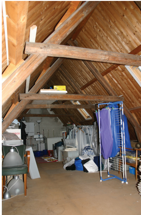
Afb. 05 Een opname van de kapconstructie aan de achterzijde.
