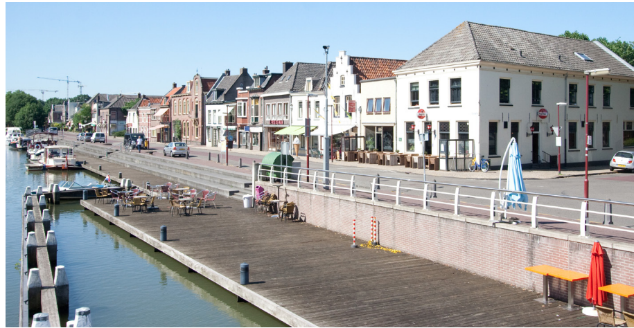
Afb. 12 De Herenstraat van nummer 18 tot en met 50. Merendeels tweelaagspanden met overwegend twintigste-eeuwse architectuur. De nieuwe kade heeft geresulteerd in een wat steriele aanblik, zeker in vergelijking met de situatie waarbij de rijbaan door bomenrijen was geflankeerd.
