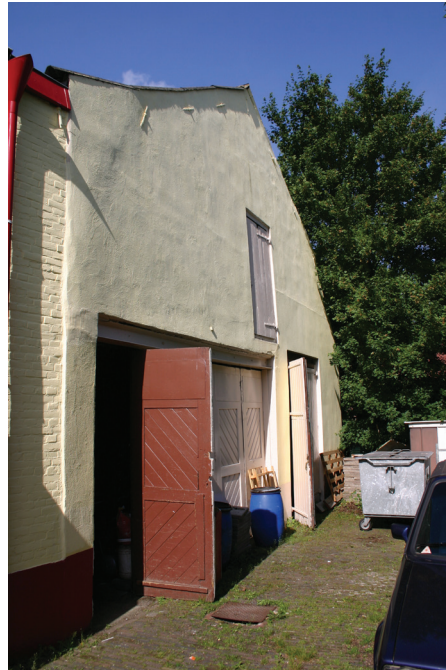
Afb. 04 De voorgevel van bouwdeel B.
