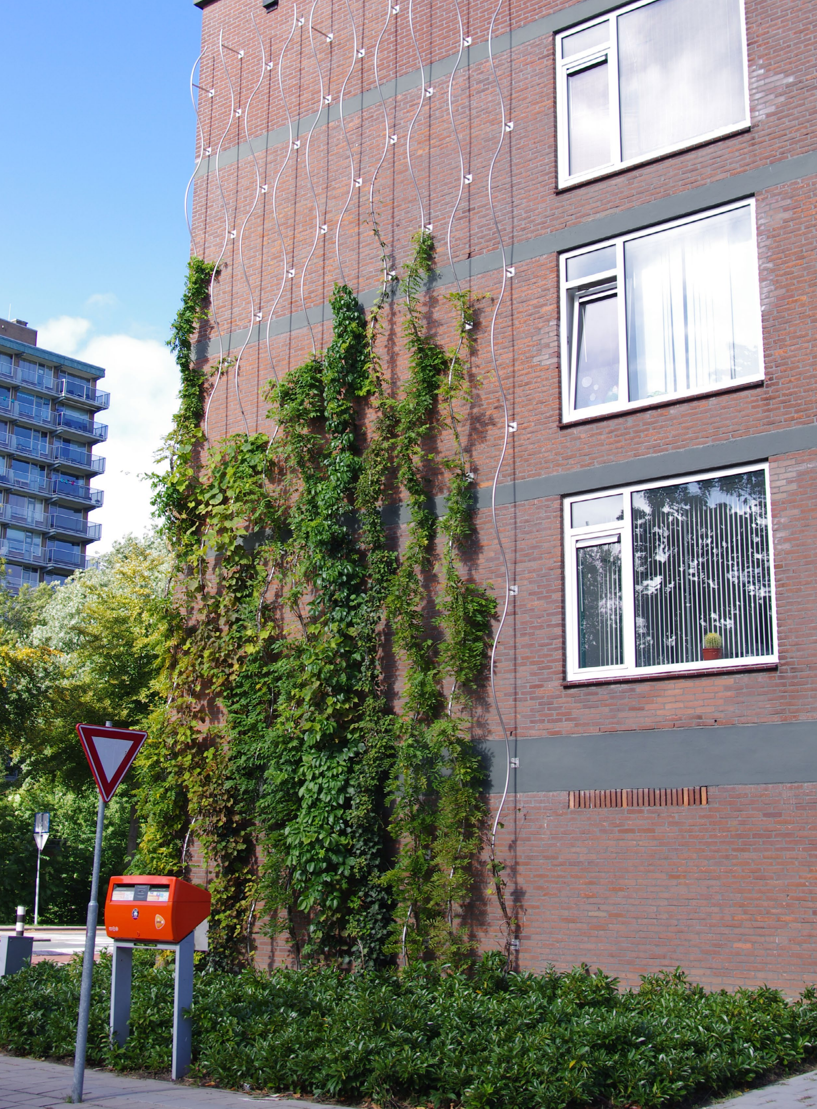
Groene gevel aan de Sluyterslaan
