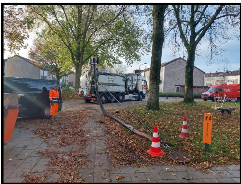
Figuur 13 Rioolreiniging
