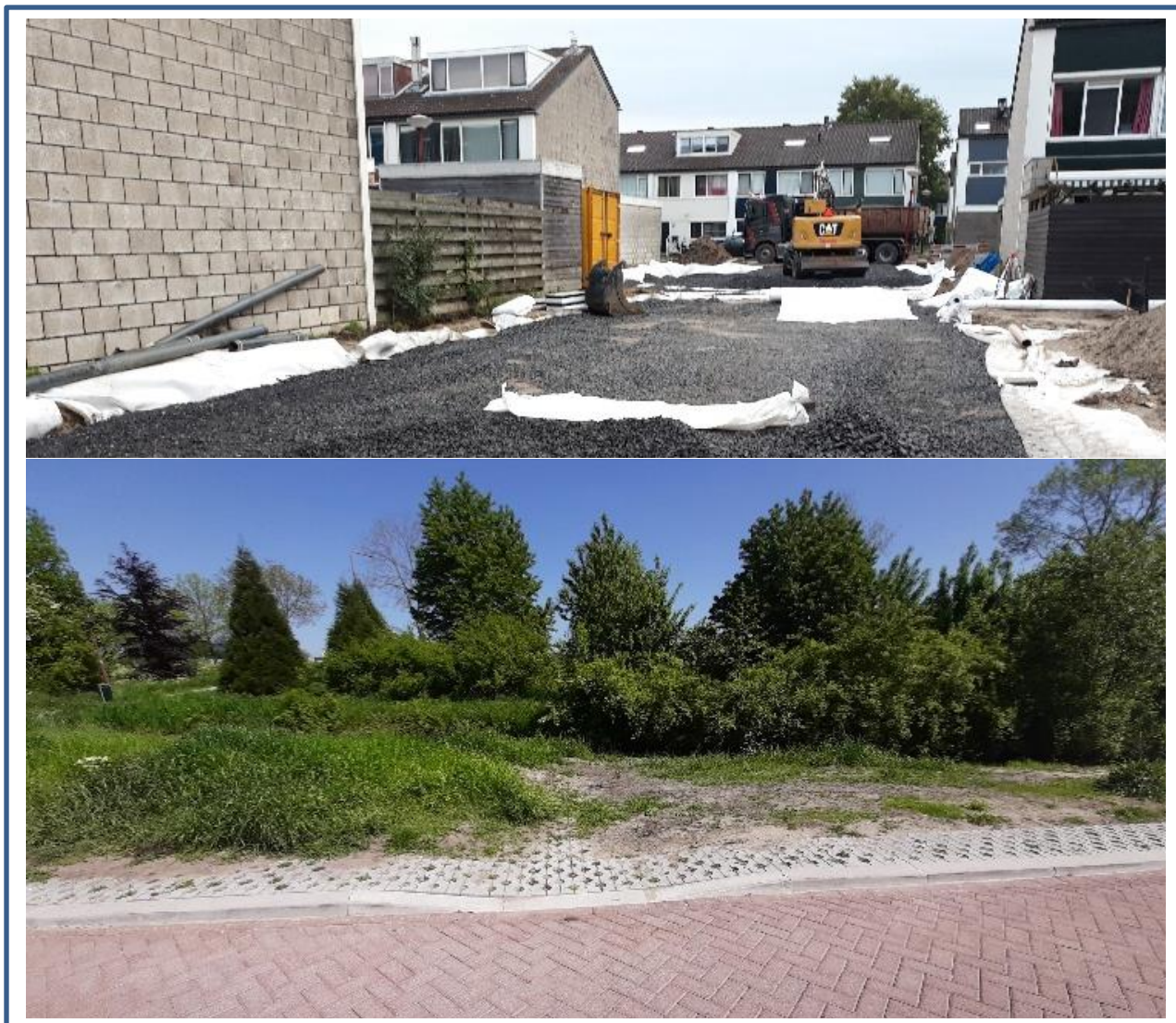
Figuur 4 Voorbeelden klimaatadaptieve inrichting. Boven: aanleg waterberging Rijtuigenbuurt. Onder: verlaagde stoeprand voor afstroming van verharding naar groen.
