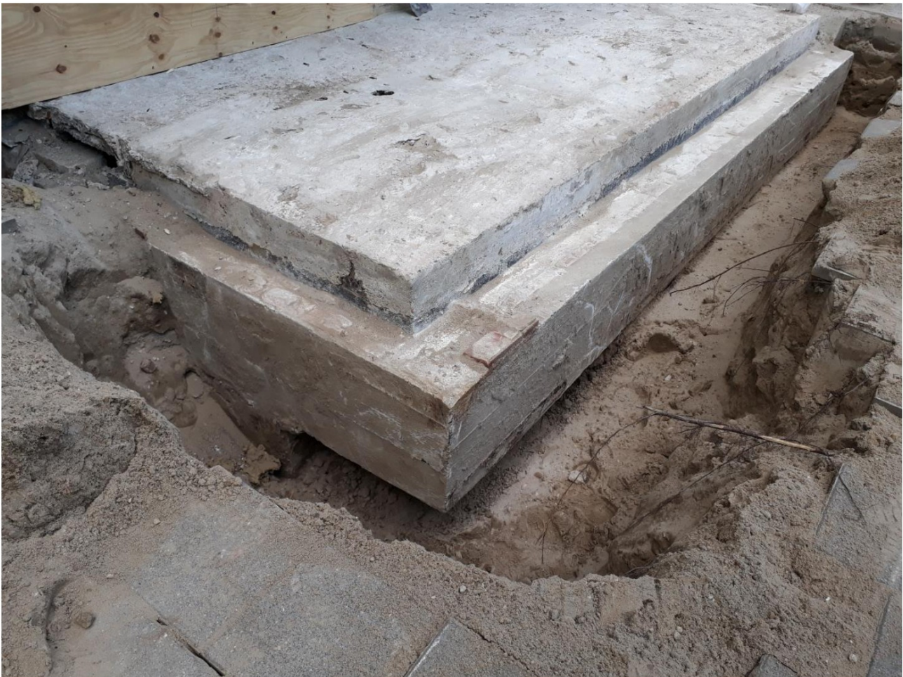
Fundering hoofdentree 's uit 1981 op 13 september 2018 uitgegraven voor aanpassing entreeportalen
