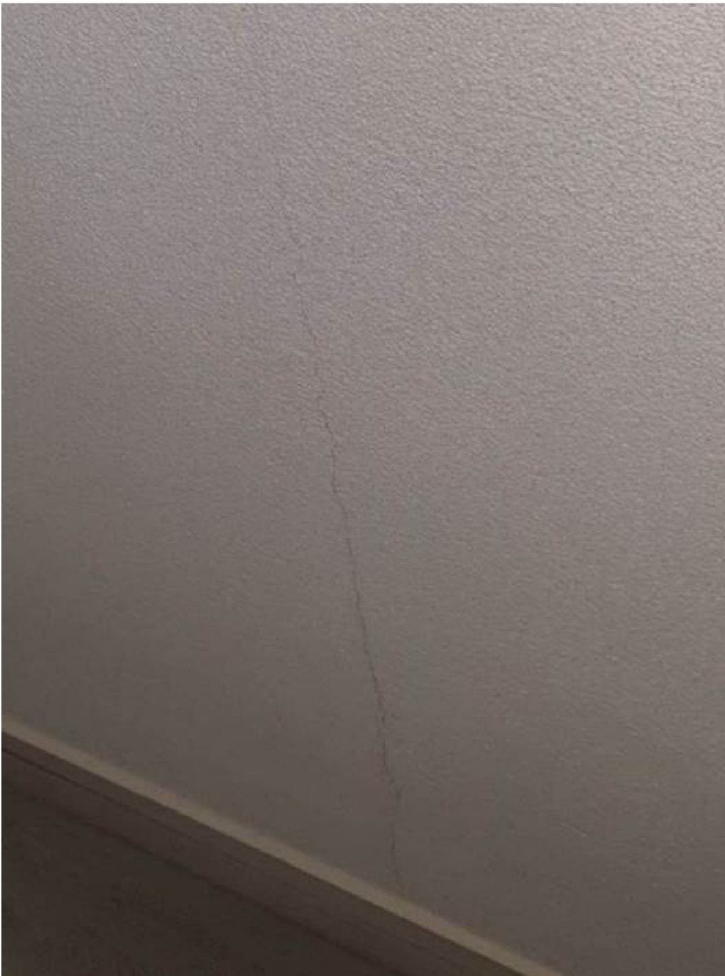
Bouwmuur, circa 2 meter vanaf galerijgevel
