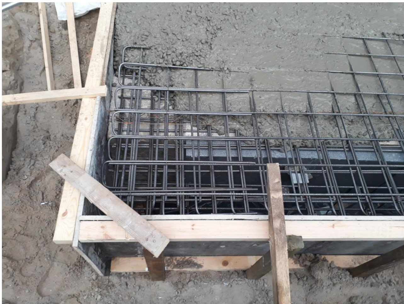
Storten uitbreiding fundering op 11 oktober 2018 voor aanpassing entreeportalen
