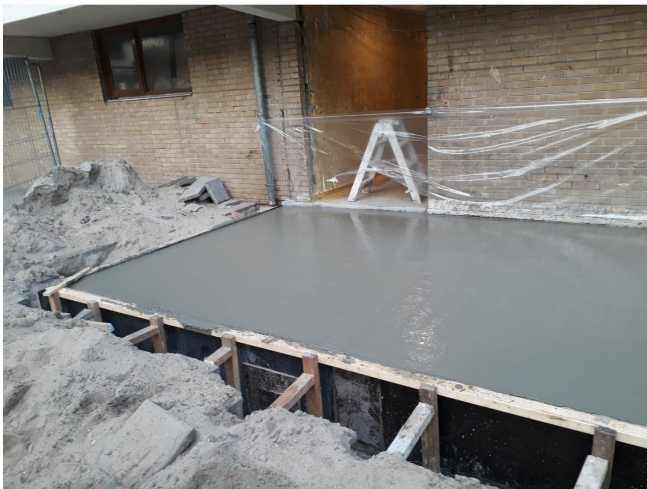
Uitbreiding fundering op 11 oktober 2018 voor aanpassing entreeportalen
