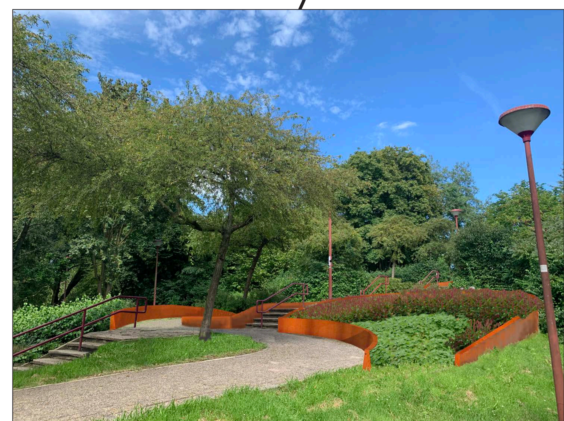
Opgang brug - cortenstaal
