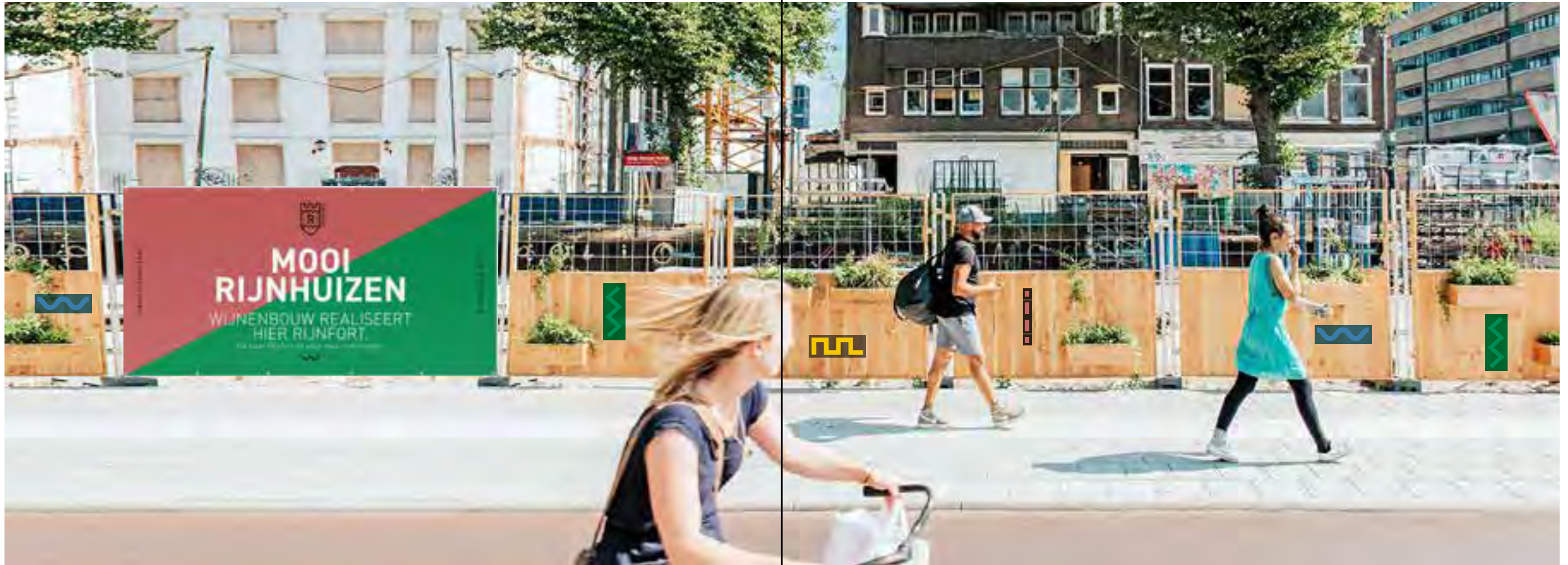
Groene bouwhekken in combinatie met de bouwhekspandoeken.
