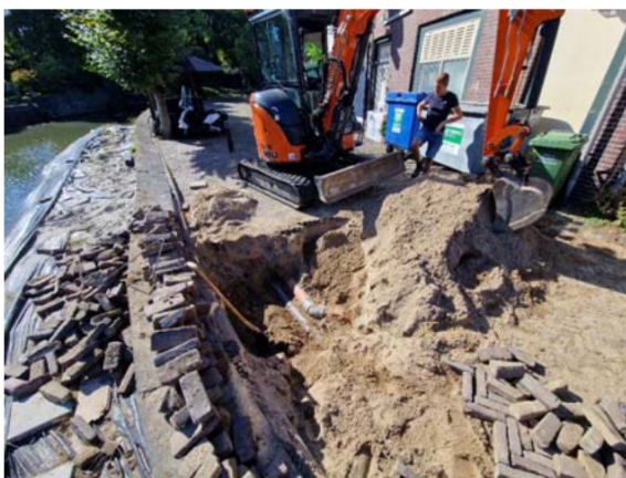
Figuur 30, locatie proefsleuf betonplaat
