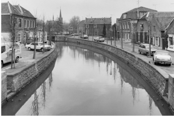
Figuur 11, voorhaven Rijkshulpschutsluis 1981
