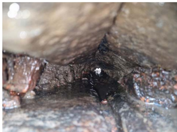
Figuur 8, open voeg tussen basalt
