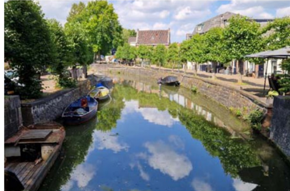
Figuur 12, voorhaven Rijkshulpschutsluis 2023
