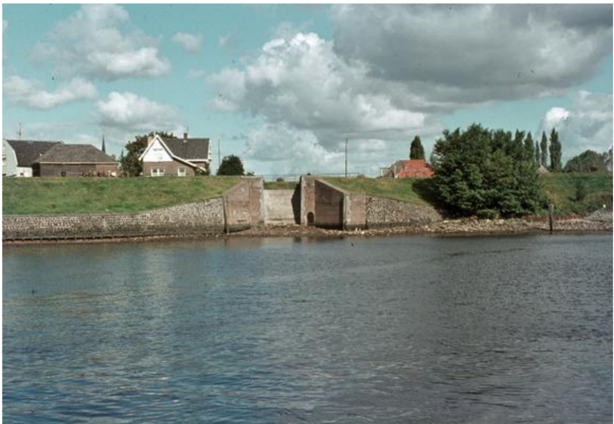
Het buitenhoofd van de Rijkshulpschutsluis na afdamming. (collectie Utrechts Archief)
