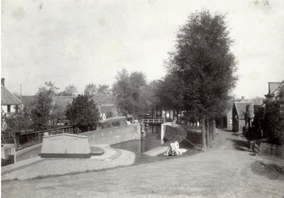
Een in 1894 vanaf de Lekdijk genomen foto, waarop het buitenhoofd, de kolk en het binnenhoofd van de Rijkshulpschutsluis te zien zijn. (collectie Utrechts Archief)
