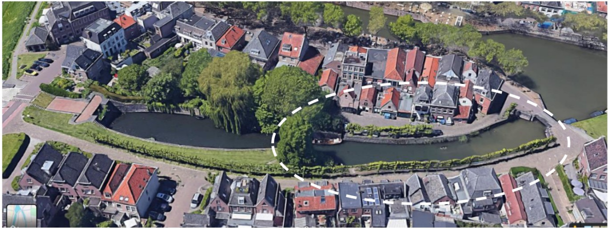
De Rijkshulpschutsluis gezien vanuit oostelijke richting. De kademuren bevinden zich in het omcirkelde deel. (Google Maps)
