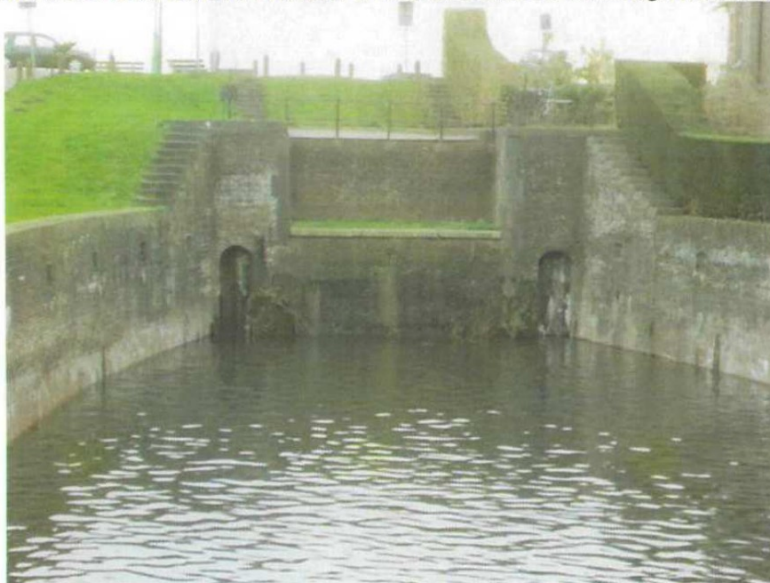
Foto 6: Dijk ter plaatse van buitensluishoofd
