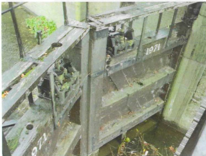
Foto 4: Set puntdeuren uit 1971 voor aanbrengen van extra houtbekleding, inclusief bewegingstoestellen rinkschuiven
