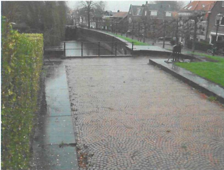
Foto 7 Buitensluishoofd gezien tussen de puntdeuren en waaierdeuren
