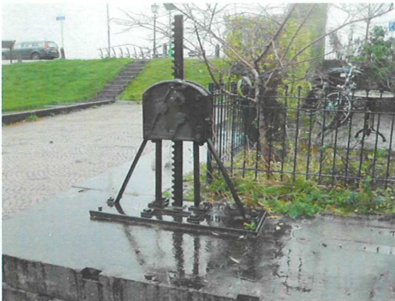
Foto 8 Bewegingswerk schuif omloopriool
