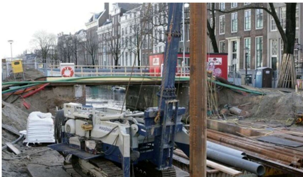
Voorbeeld machine aanbrengen schroefpalen
