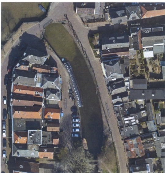
Voorhaven Rijkshulpschutsluis (Spuisluis)
