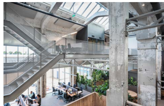
insteekvloer en lichte kapconstructie
