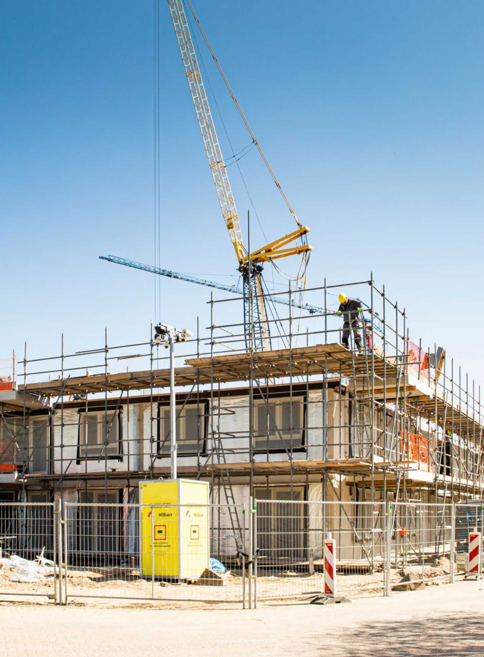
Werkzaamheden bij een woningbouwproject in Nieuwegein.
