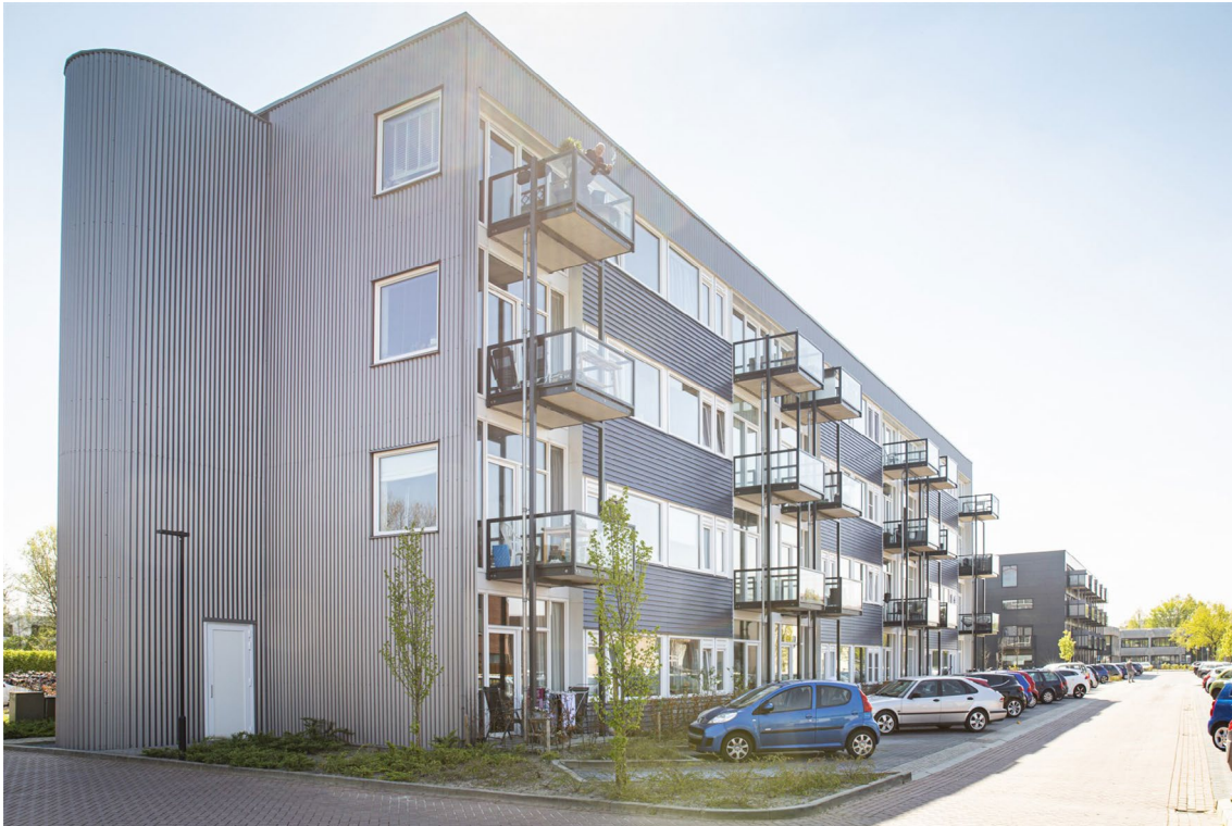
Eén van de vele kantoortransformaties in Nieuwegein.
