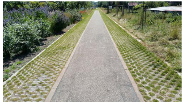
Voetpaden worden waar nodig tot 3.5m aangevuld met grasbetontegels.
